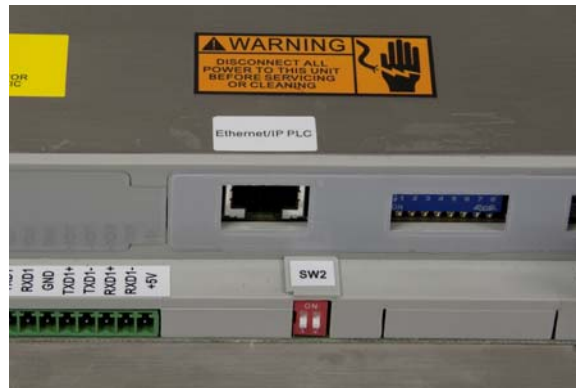
Figura 2-47: Colocación de la etiqueta Ethernet/IP, caja de montaje en panel
