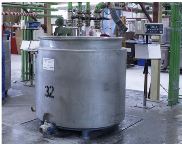
Nádrž s odpojeným potrubím
