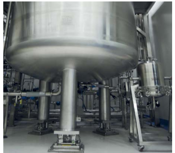
Phần dưới của lò phản ứng được lắp đặt trên các mô đun cân chịu nén linh hoạt
