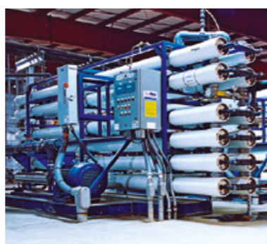
Prétraitement de l'eau
