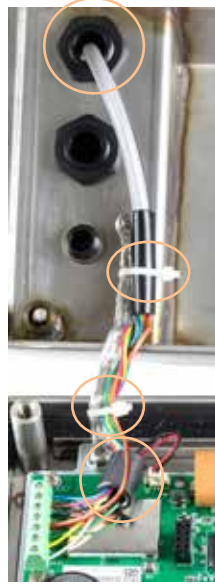
Figure 2-24 : Broche de masse du capteur analogique et installation de la ferrite, IND236
