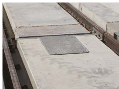
Plateforme en ciment
