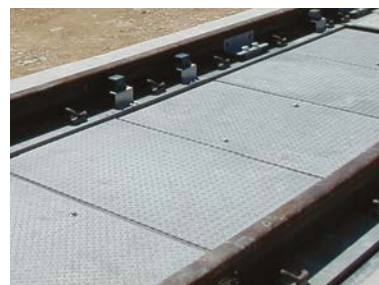
Plateforme en acier
