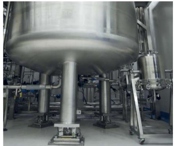
Der untere Abschnitt des Reaktors ist auf flexible Drucklastwägemodule montiert
